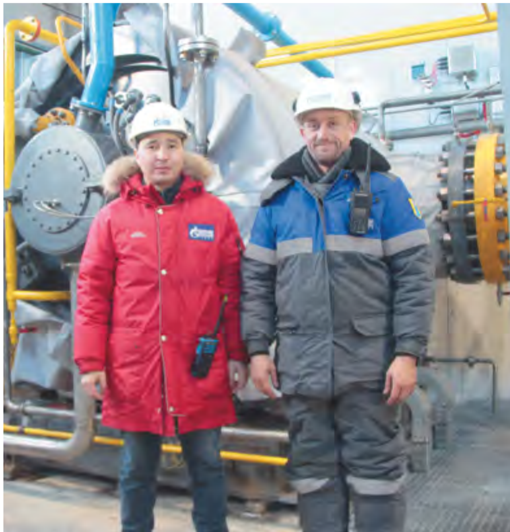
Инженер производственного отдела по эксплуатации компрессорных станций Олег Холодов и начальник газоконпрессорной службы Свободненского ЛПУМГ Иван Ермаков работают плечом к плечу
